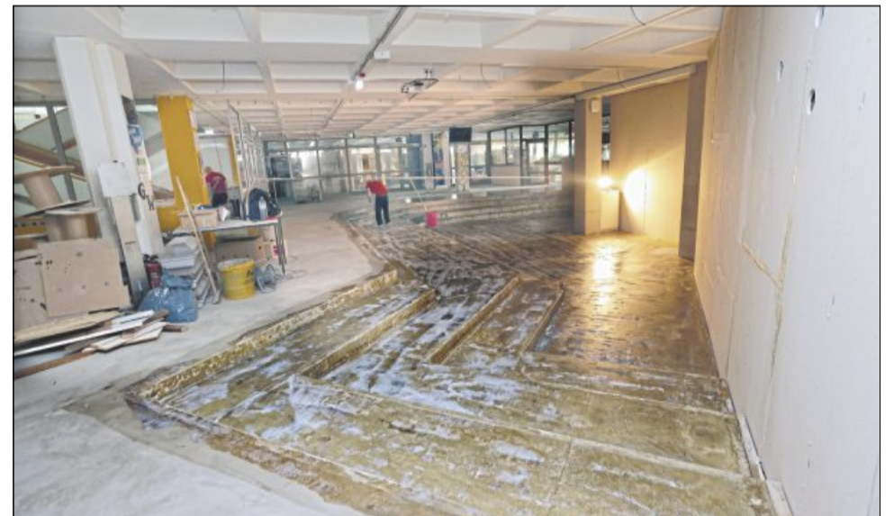
Der Aula-Bereich des Gymnasiums wurde auch verändert.
