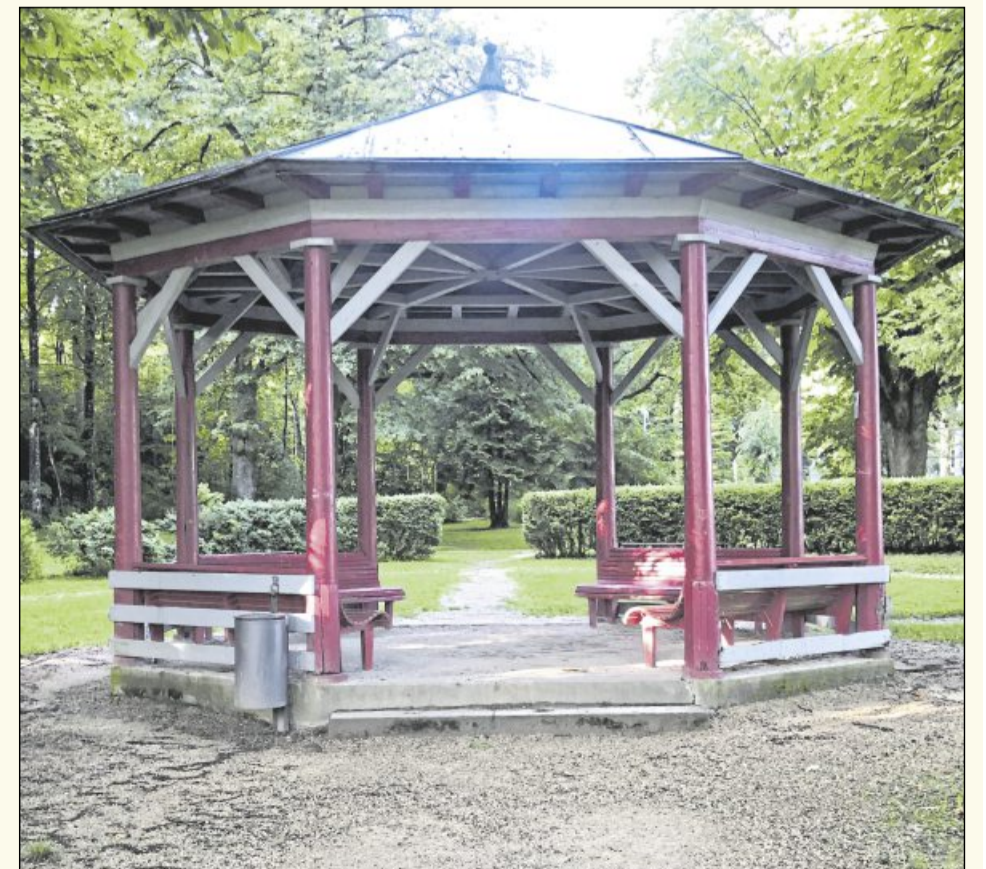
Der Pavillon im Welzheimer Stadtpark sollte dringend saniert werden.
