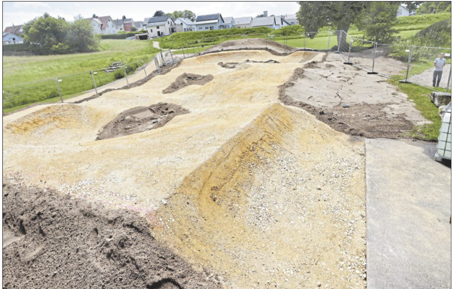
Der neue Pumptrack ist bald fertig – man kann die Streckenführung schon gut erahnen.
